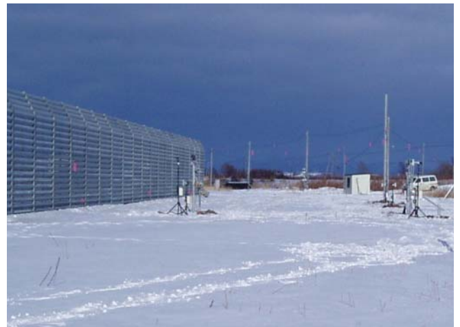
写真1 防雪柵の防雪性能計測状況
