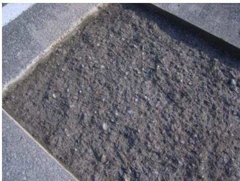
写真-4 第2径間の舗装はつりの状況
