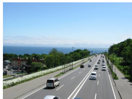
写真-4 舗装をアスファルトで統一した郊外道路(北海道)
