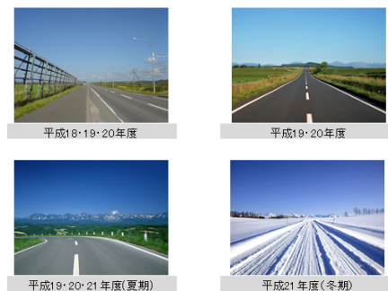
写真-1 道路の内部景観写真
