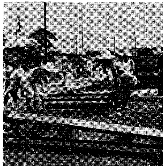
コンクリート締固め
