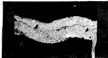
写真—3 塗布後凍結融解 200 cycle (ひびわれ面の塗膜は切断されていない)
