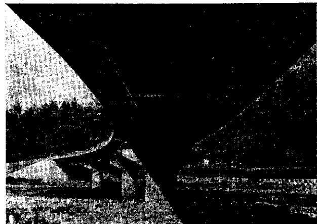
写真-3 中愛別橋 (下面より見る)
