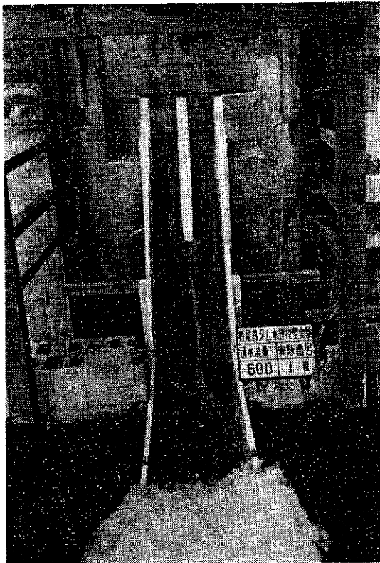
写真-7 通水状況 流量 600 m 3 /s
