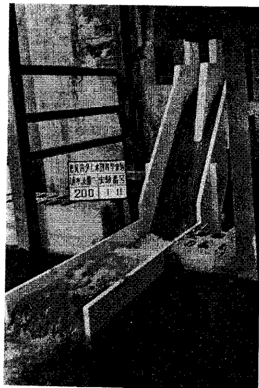
写真-6 通水状況 流量 200 m 3 /s
