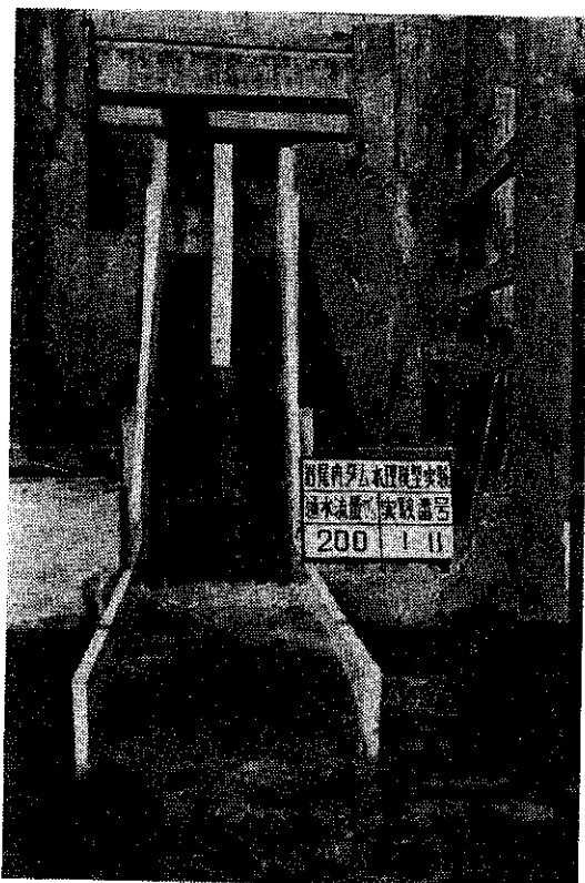
写真-5 通水状況 流量 200 m 3 /s
