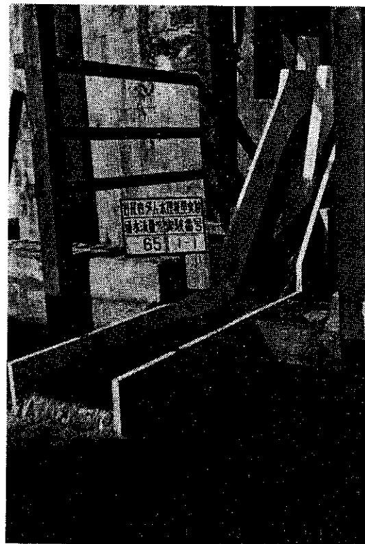
写真-4 通水状況 流量 65 m 3 /s
