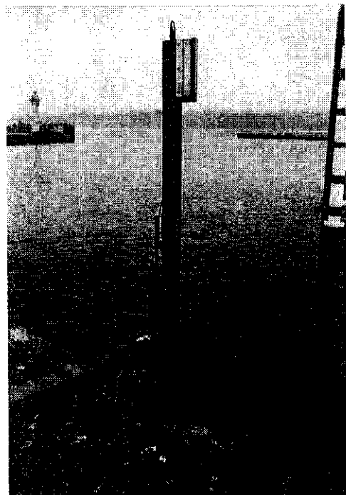
写真-7 電極ボールの上部構造 (C地点)
