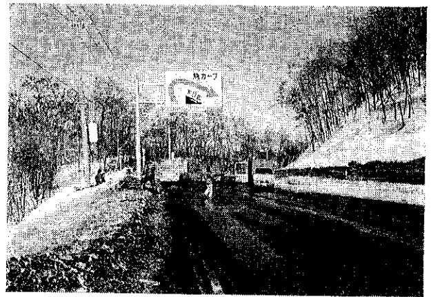
写真—13 豊滝冬季標識設置後
