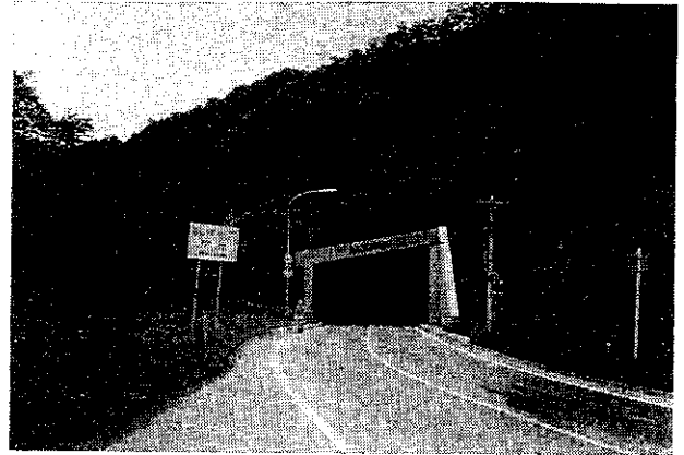
写真—6 日勝峠夏期標識設置前(日高方向)
