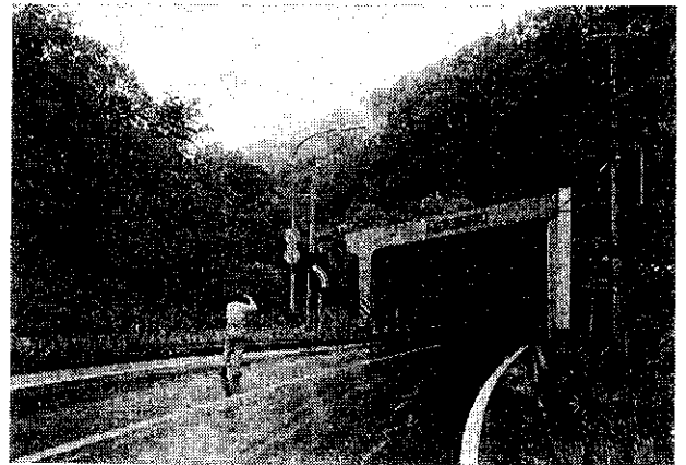
写真—7 日勝峠夏期標識設置後(日高方向)
