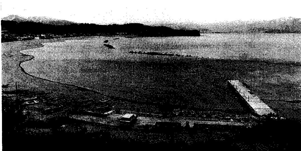
写真-1 蘭島地区全景（昭和61年4月撮影）
