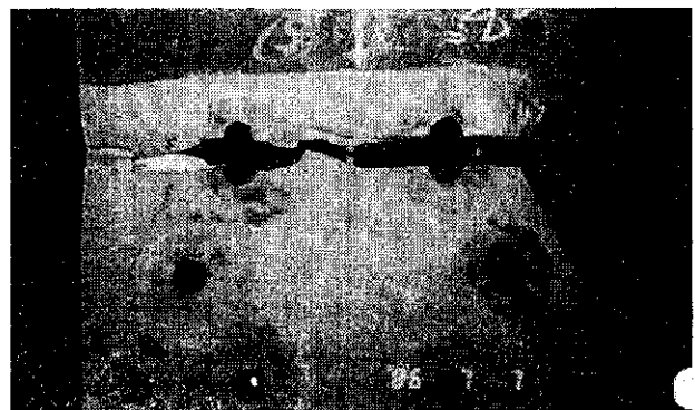
写真-5 Cげた下フランジ破断状況
