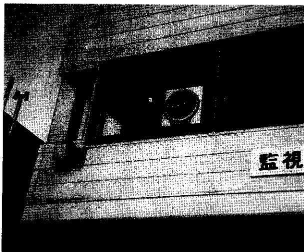
写真-1.2 雪氷防止用カメラ収納ケースの窓枠取り付け状況
