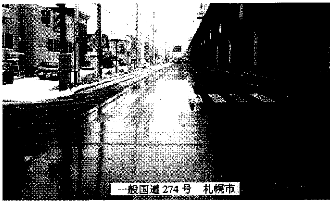
写真-2 路面状況（排水性舗装）
