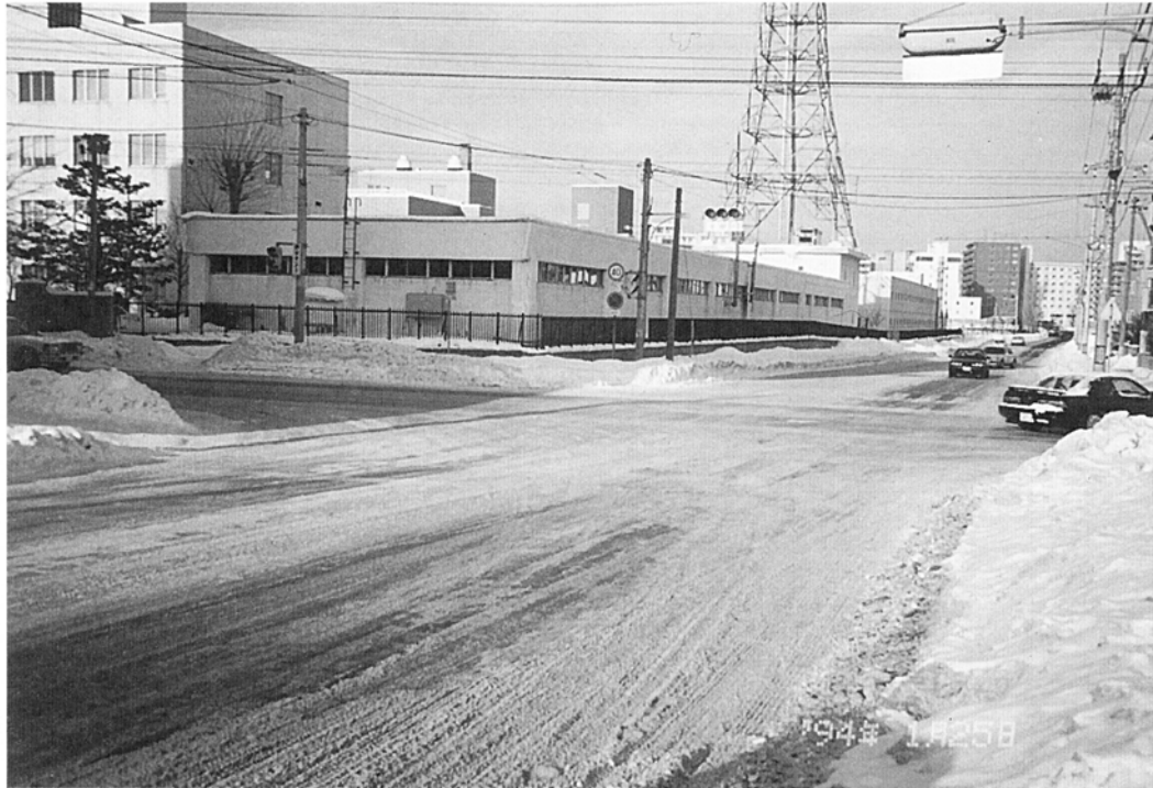
写真-1 水と氷が混合し、シャーベット状になっている路面
