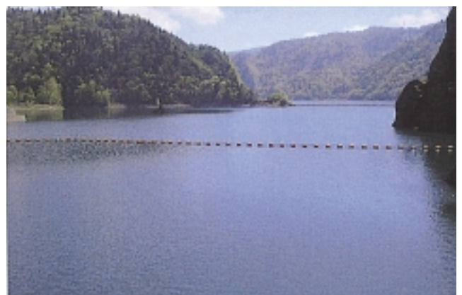
写真 - 2 ダム堤頂から上流側の眺望
