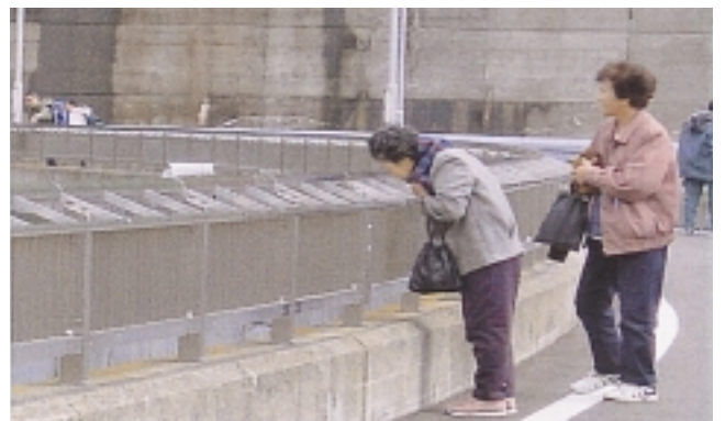
写真-4 上部構の隙間から谷底を覗き込む人
