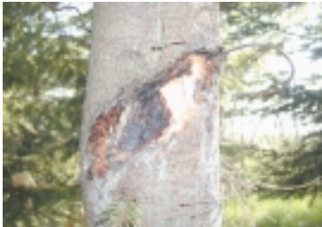
写真 - 4 八つがけ支柱による損傷
