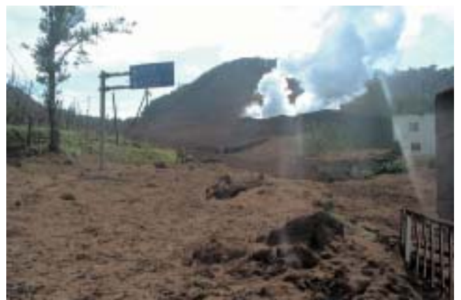
写真 - 2 被災状況（木の実橋）
