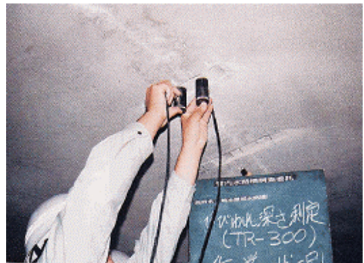
写真-1 超音波法を用いて実構造物のひび割れ深さ検査状況
