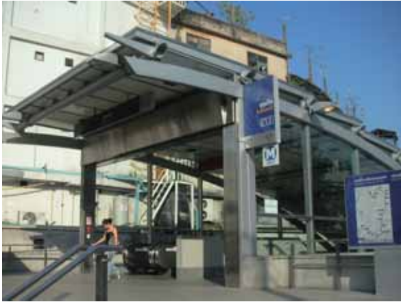
写真－7 開通間もない地下鉄の駅
