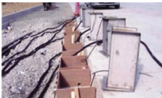
写真－7 試験道路の計器埋設状況
