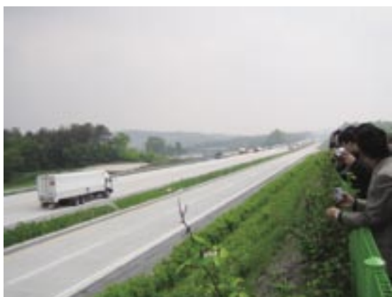
写真－5 試験道路の全景 （手前の 2 車線が試験道路）
