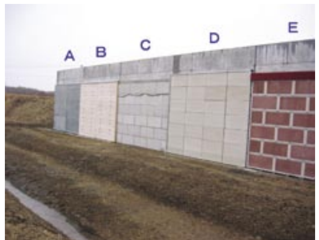
写真－1 屋外実大試験全景
