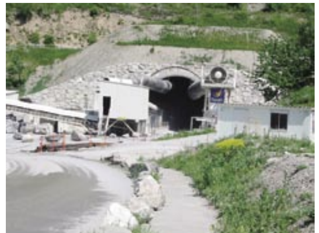
写真-7 St-Martin La Porteのトンネル坑口
