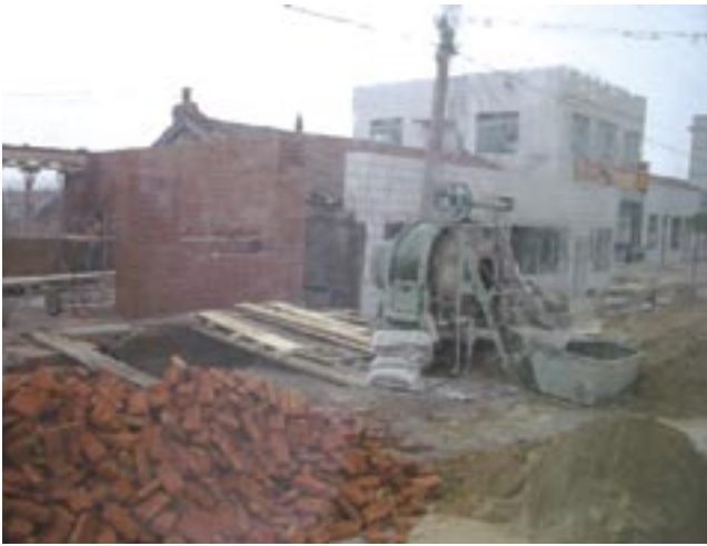
写真-11 コンクリートやモルタルの現場練り
