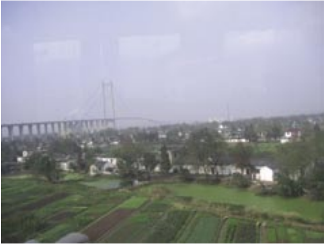
写真－6 潤揚大橋と郊外の風景
