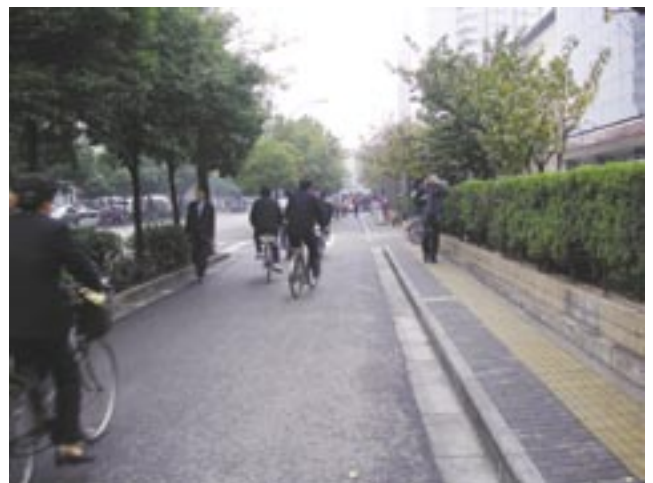
写真－9 車道（左）、二輪車道（中央）、歩道（右）
