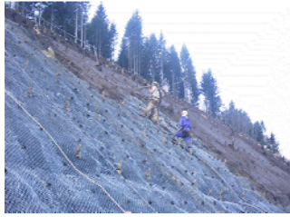
写真7 植生基材吹付工の施工状況
