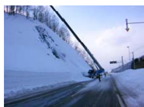
写真2 平成15年冬の雪落とし状況
