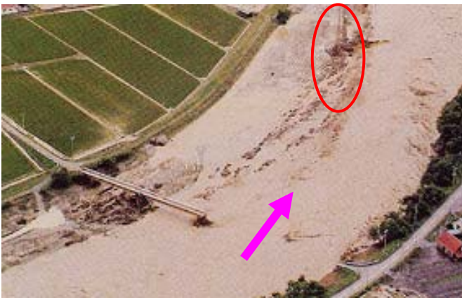
写真-4 アブシトエナイ橋の被災状況 (北海道開発局提供)
