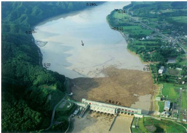
写真-1 二風谷ダムに貯留された流木 (北海道開発局提供)
