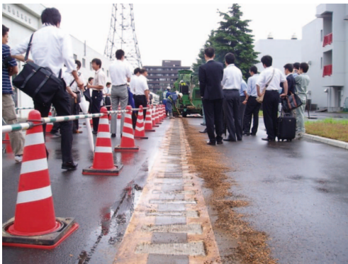
施工直後の状況
