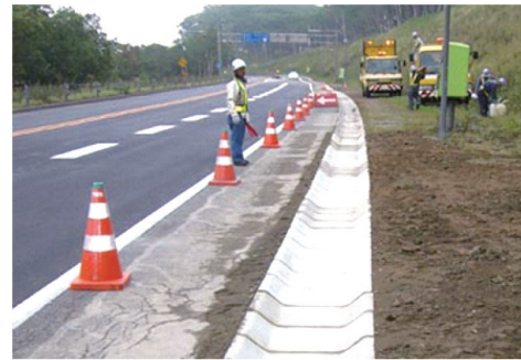
改質セメントを用いた皿形ブロックの試験施工
