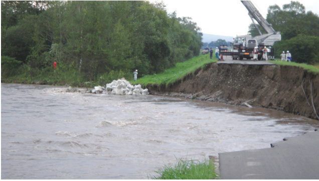
図－3 音更川(KP18.2)における堤防被災状況及び災害対策状況
