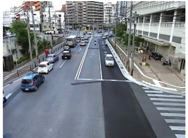
写真-6 那覇市内の舗装 (比較的白っぽく感じられる)
