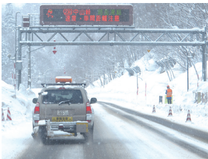
連続路面すべり抵抗値の測定状況
