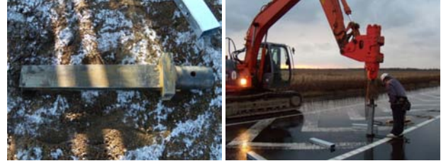
写真-6 作成したアタッチメント (左) と施工状況 (右)
