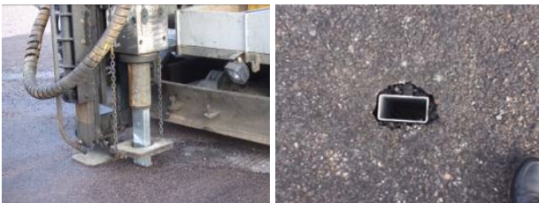
写真-5 支柱の施工機械 (左) と施工後のスリーブ管 (右)
