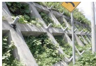
写真-3 フリーフレーム施工箇所
