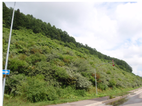
写真-1 側道のり面部の状況
