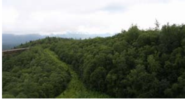
写真-8 左が盛土部, 真中が旧道, 右が無種子吹付切土部
