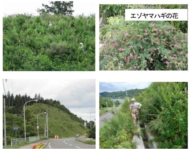
写真-4 西興部工区の調査状況
