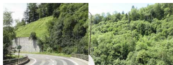
写真-5 樹林化の進んでいない現道部の施工箇所(左)及び樹林化の進行が早い旧道敷の施工箇所(右)
