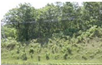
写真-2 植生マット施工箇所
