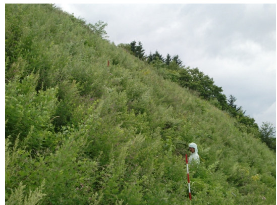
写真-3 硬岩を含むのり面へ中低木導入した西興部のり面
