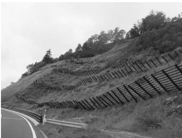
写真1 雪崩予防柵の施工状況
