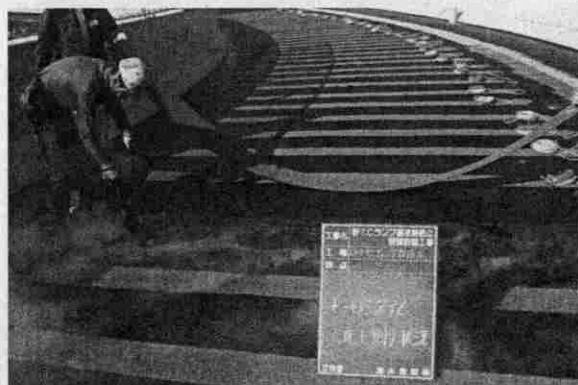
写真 4 - 125 面状発熱体の布設状況 (奈良県都祁村：国道25号針ICランプ橋)
