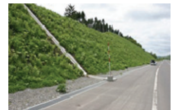
写真-1 のり面への中低木導入例
