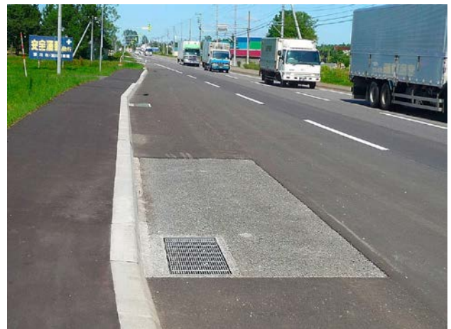
写真-1 試験施工現場写真
