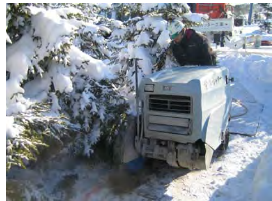
写真-4 ロードカッターによる根切り
