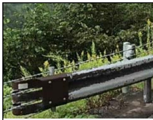
写真-8 道路施設の塗装が剥がれた事例
