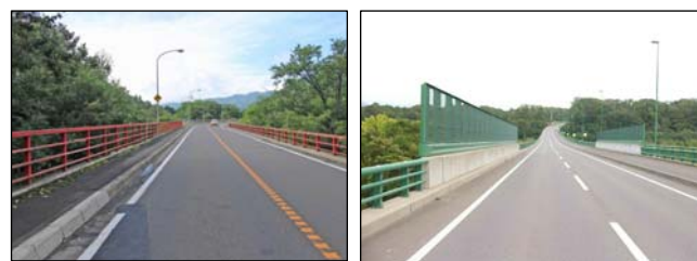
写真-5 橋梁高欄の色彩(左：朱色、右：グリーン系)
