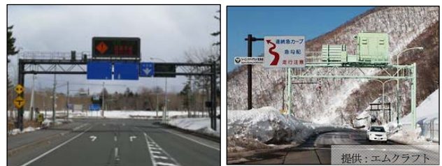
写真-1 道路施設の色彩事例
