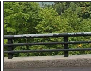
写真-8 道路施設の塗装が剥がれた事例
