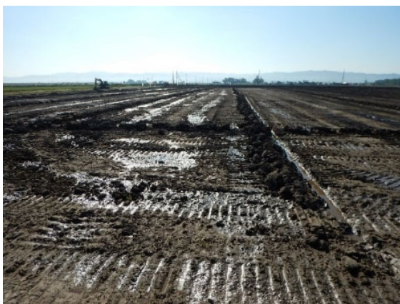
写真-1 施工後に土壌の物理性が悪化した圃場
