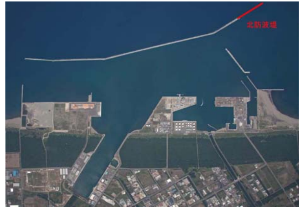
写真－1 北防波堤施工箇所
