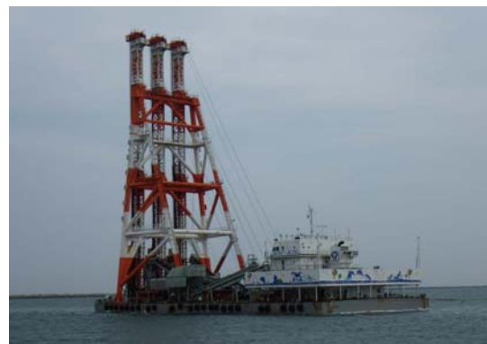
写真-2 SCP船全景
