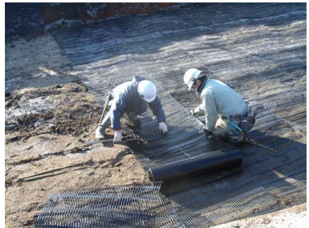
写真-3 ジオテキスタイルの接合作業
