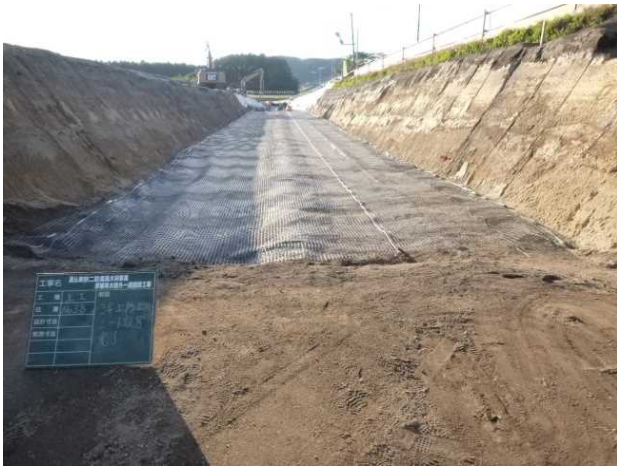
写真-5 ジオテキスタイル敷設終了
