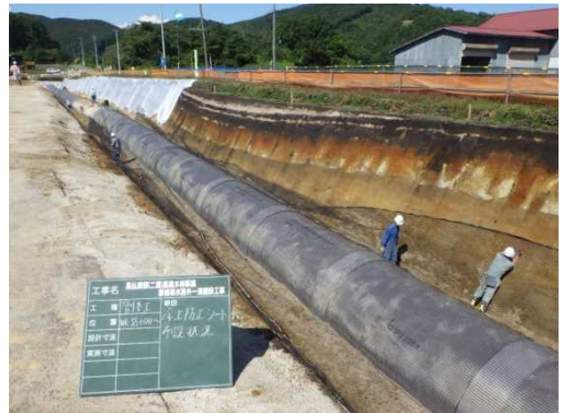
写真-2 ジオテキスタイル敷設状況
