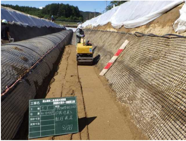
写真-4 管側部の転圧作業
