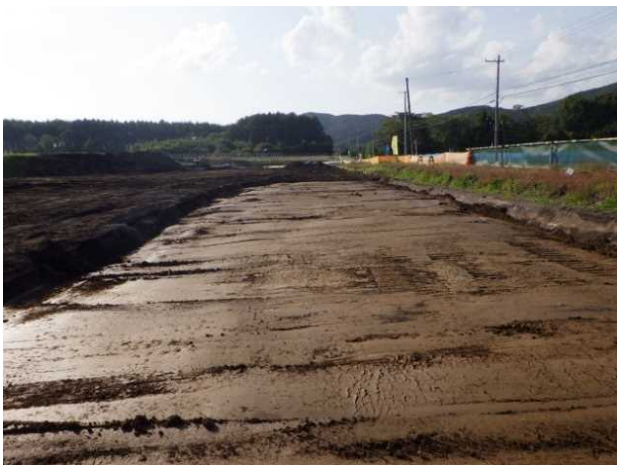
写真-6 埋め戻し終了
