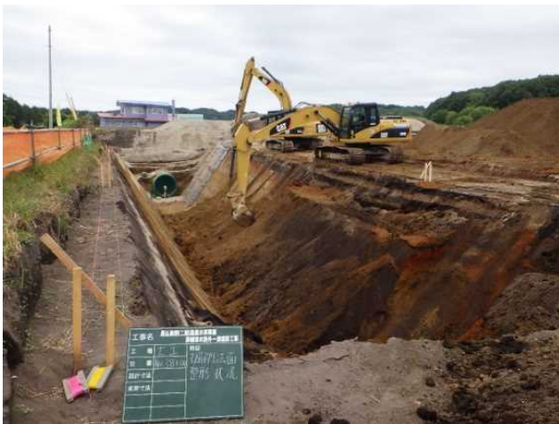
写真-1 掘削状況
