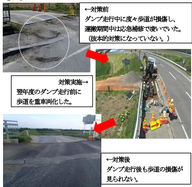
写真-1 運搬ルート損傷箇所の対応
