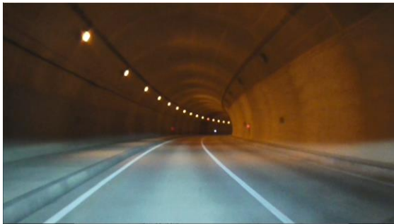
写真-1 神岬トンネル基本照明点灯状況(昼)
