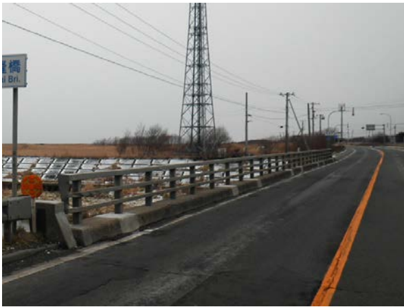
写真-1 国縫橋の路側帯の状況 (完成後)
