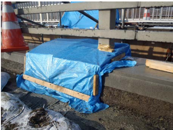
写真-3 ブルーシート養生
