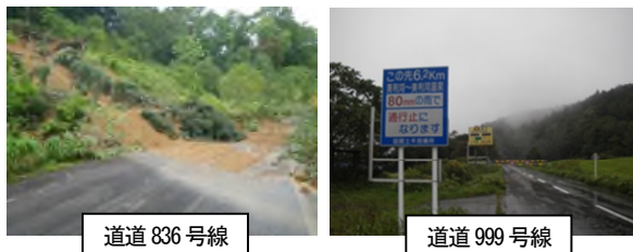
図-2 土砂崩れ・通行止め措置
