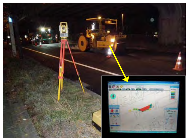
写真-3 転圧回数の管理
