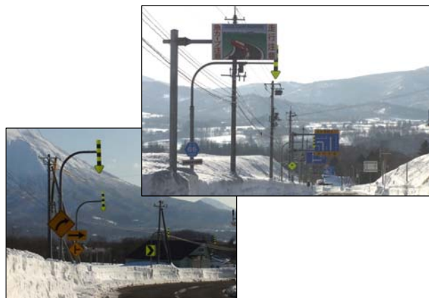
写真-2 道路空間に設置される様々な付属施設類
